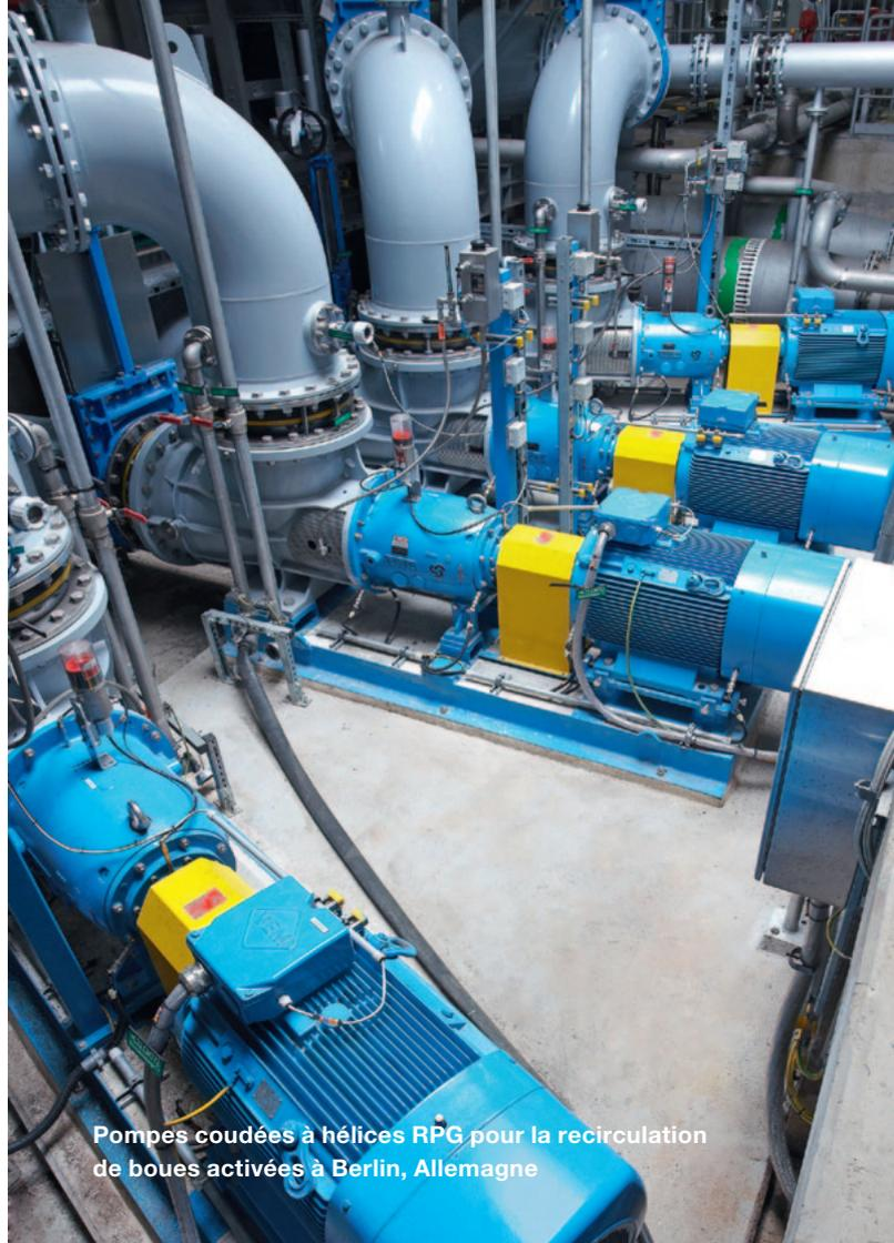
Pompes coudées à hélices RPG pour la recirculation de boues activées à Berlin, Allemagne
